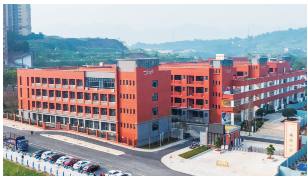
德感小学改扩建工程(一期)完工并交付开学
