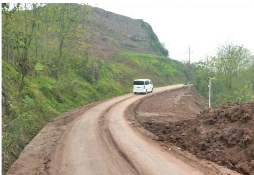
即将完工的农村公路
