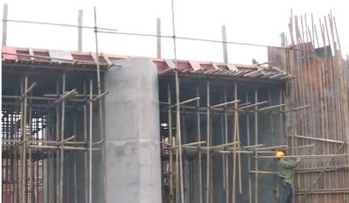
工地进行全封闭施工
