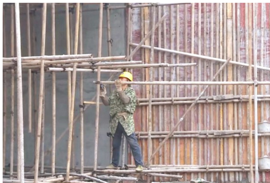
工人正在紧张施工
