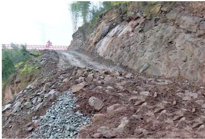
施工车辆对公路造成损坏
