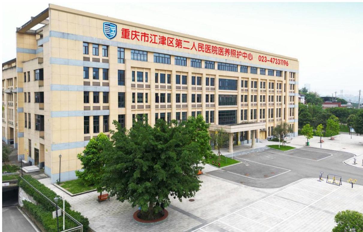
区二院医养照护中心
