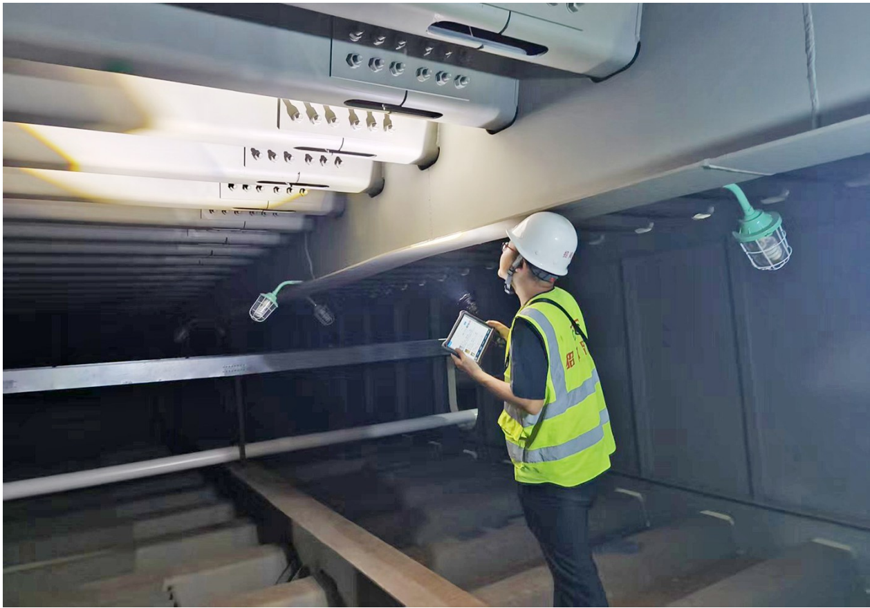
工作人员在大桥钢箱梁内部检查 区城市管理局供图
