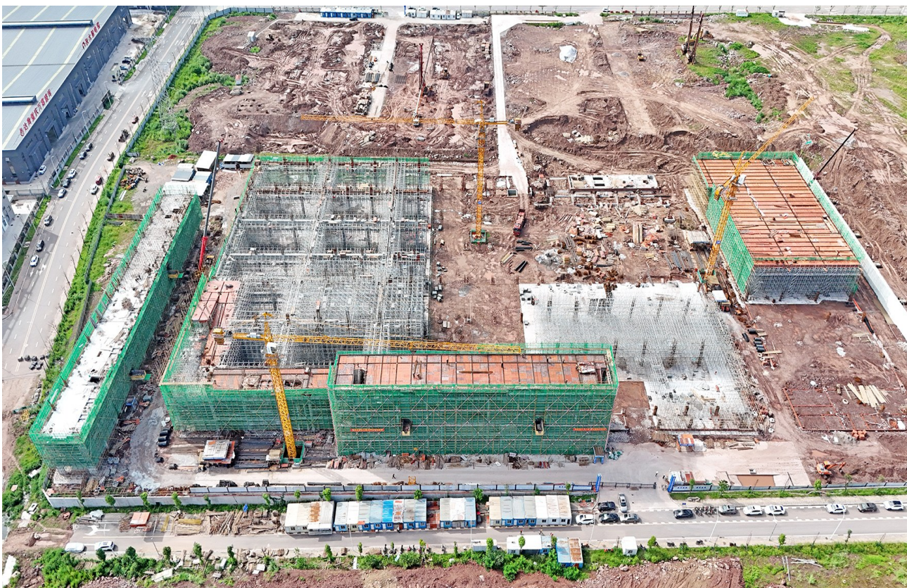
项目建设现场 记者 刘星欣 摄
