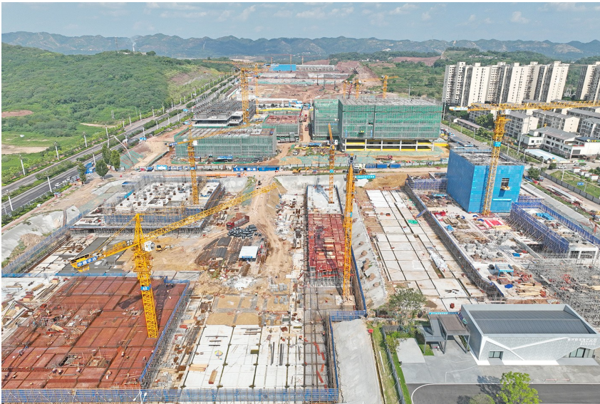
先进机电装备和物流产业园项目建设现场
