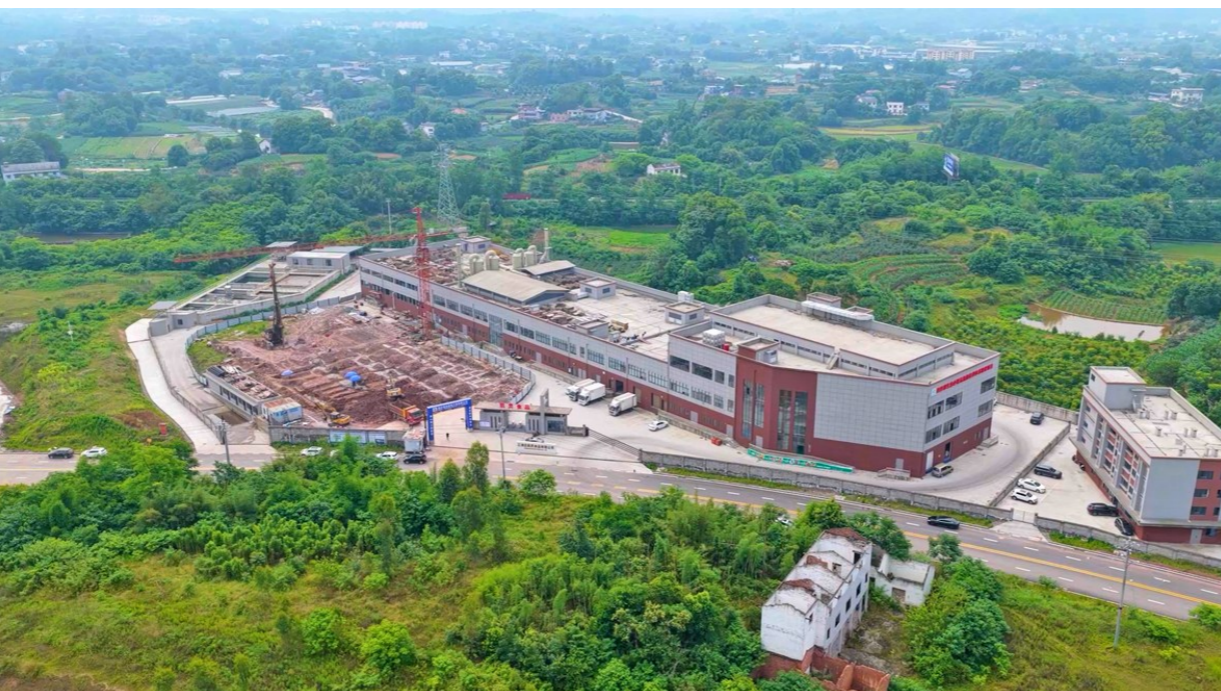
凯灵肉禽深加工二期项目建设现场
